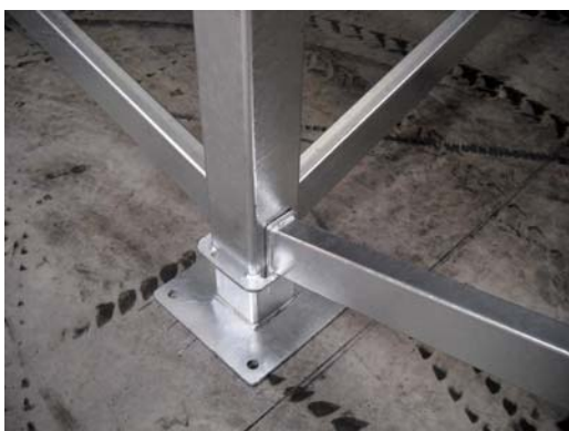
Encrage bas : pieds-poutre de renfort
