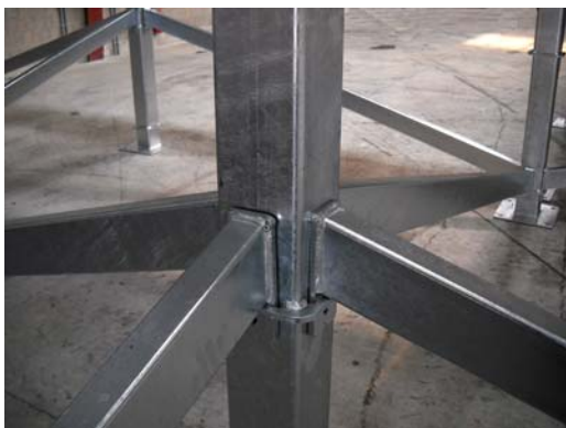
Encrage haut : pied-poutre de renfort
