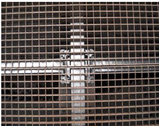
Encrage de poutre et caillebotis
